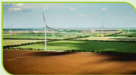
Мал. 122. Ботіївська вітрова електростанція
