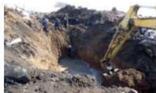
Іл. 34.11. Викопування водовідвідної каналу
