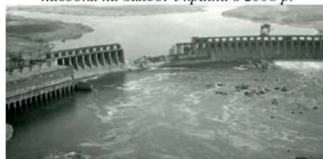
Іл. 33.7. Зруйнована вибухом гребля Дніпрогесу в 1941 р.
