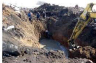
Іл. 33.11. Викопування водовідвідної канави
