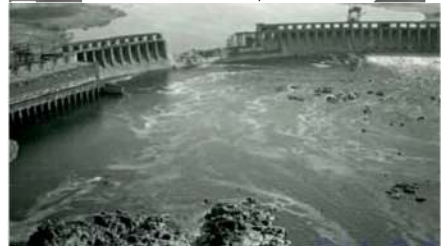
Іл. 32.7. Зруйнована вибухом гребля Дніпрогесу в 1941 р.
