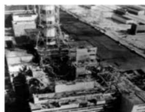
Іл. 32.14. Аварія на Чорнобильській АЕС
