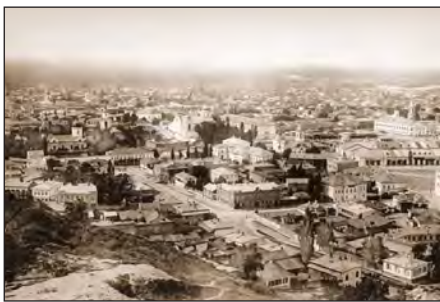
Загальний вигляд Подолу в Києві. Листівка початку XX ст.
