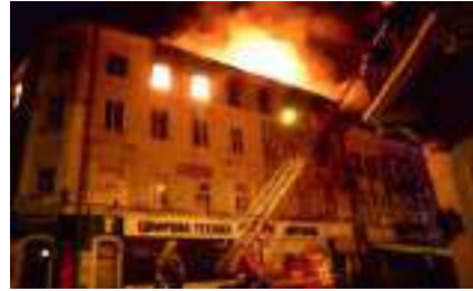
Іл. 43.5. Пожежа в центрі Тернополя в 2015 р.
