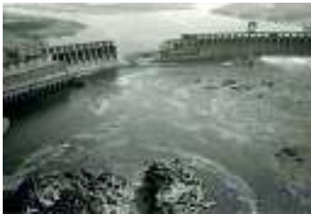
Іл. 42.8. Зруйнована вибухом гребля Дніпрогесу в 1941 р.
