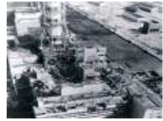
Іл. 42.10. Аварія на Чорнобильській АЕС
