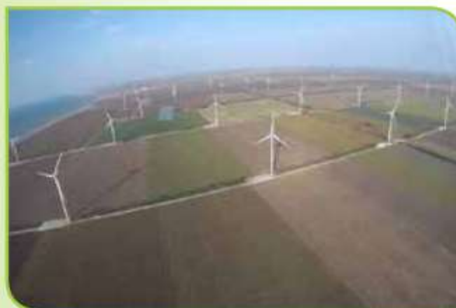
Ботіївська вітрова електростанція
