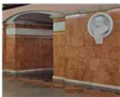
Плитка з мармуру на станції метро
