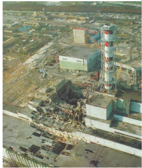
↑ Зруйнований четвертий реактор ЧАЕС
