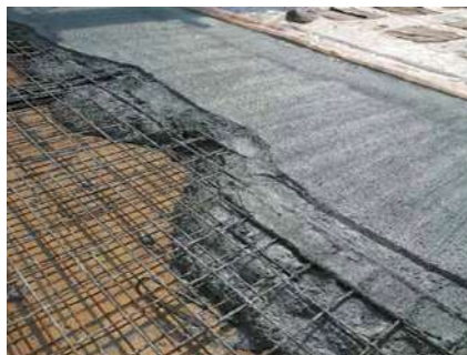
Мал. 30.10. Заливання арматурного каркасу бетоном
