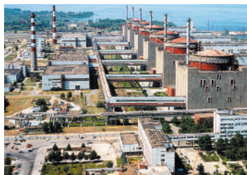
Рис. 42.6. Запорізька АЕС — найбільша атомна електростанція Європи: 6 атомних енергоблоків потужністю 1000 МВт кожен
