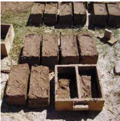
Мал. 151. Виготовлення цеглин із саману (а); внутрішня обробка глиною (б)
