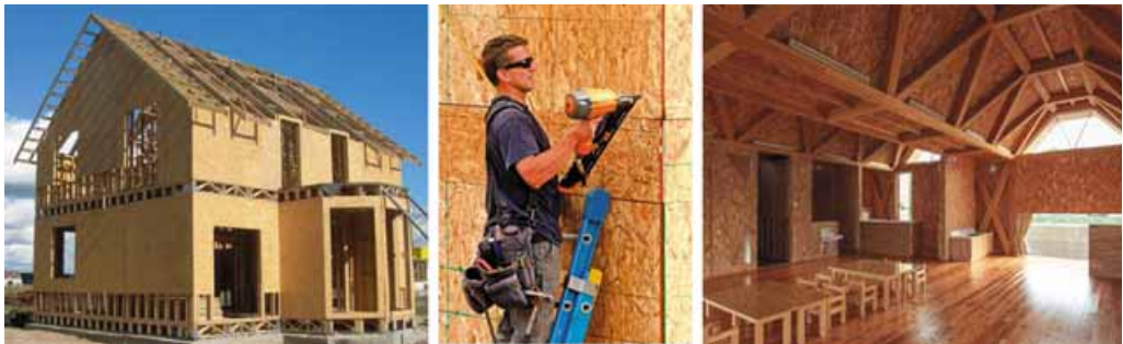
Мал. 25. Застосування ОСП: а – обшивання стін будинку; б – обшивання дахів
