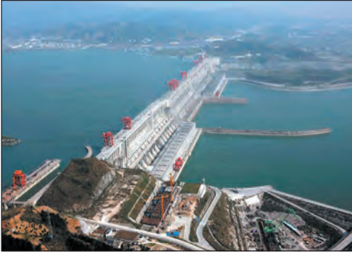
Мал. 3. ГЕС «Сан-Ся» (Китай). Довжина греблі ГЕС становить 2309 м, висота — 185 м, тому іноді її навіть порівнюють із Великою Китайською стіною. Будівництво ГЕС тривало понад 15 років. Зараз вона не тільки виробляє електроенергію, а й використовується для регулювання річкового стоку, зрошення та водозабезпечення.
