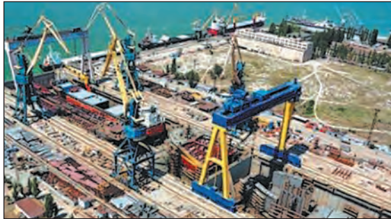
Мал. 6. Суднобудівний завод «Океан» у Миколаєві. Його потужності розраховані на будівництво та ремонт великих середньотоннажних і великотоннажних суден різного класу й призначення.
