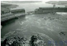
Іл. 40.8. Зруйнована вибухом гребля Дніпрогесу в 1941 р.
