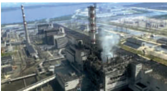
Іл. 41.2 Аварія на Чорнобильській АЕС
