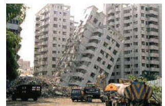
Іл. 40.15. Наслідки землетрусу
