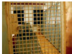
Іл. 11.4. Кімната для зберігання зброї з металевими ґратами на вікнах і дверях й охоронною сигналізацією
