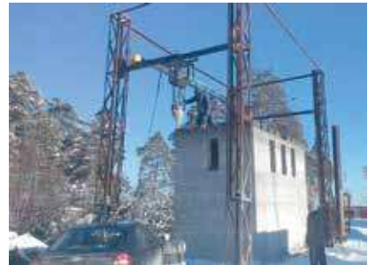
Мал. 2.105. Будівельний 3D-принтер
